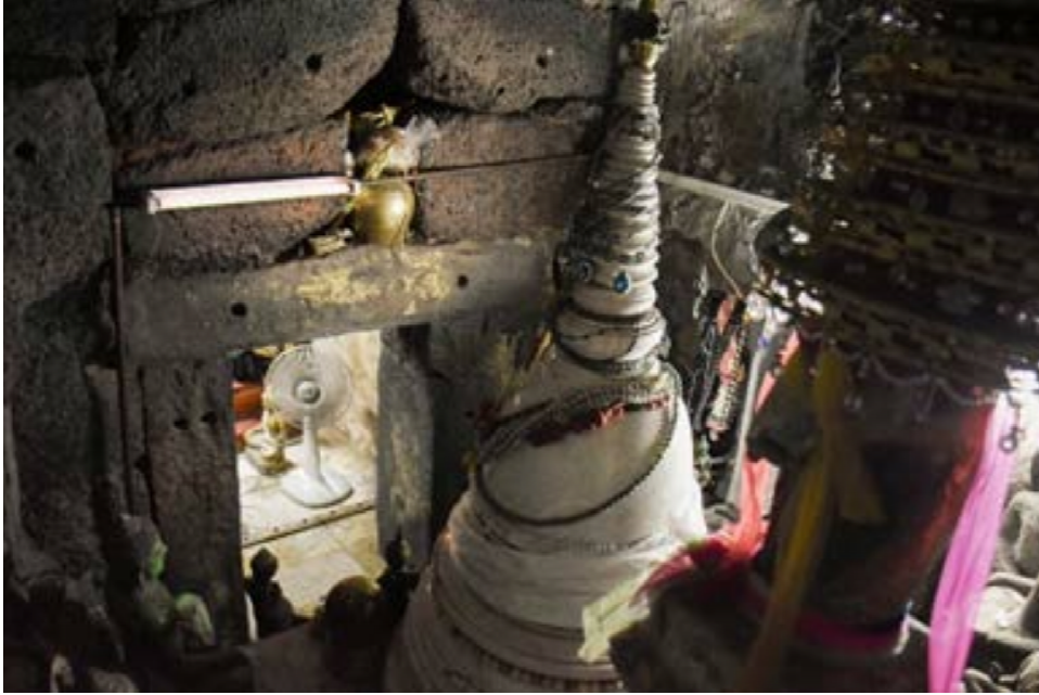
ภาพที่ ๔ : พื้นที่ภายในเรือนธาตุหรือห้องครรภคฤหะองค์พระธาตุเชิงชุมมองจากภายในด้านทิศตะวันออก มีการใช้ “หินทราย” (sandstone) เป็นส่วนประกอบในการทำรอบประตู เพื่อรับน้ำหนักจากการทิ้งตัวของเรือนยอด
