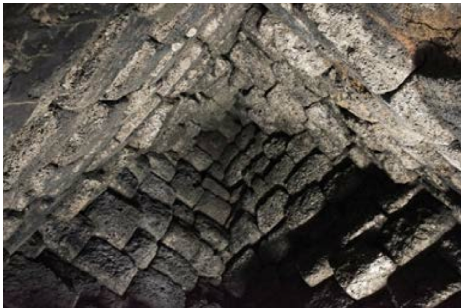
ภาพที่ ๓ : โครงสร้างภายในเรือนธาตุ หรือ ห้องครรภคฤห องค์กรธาตุเชิงชุม ก่อด้วยหินแลง (Laterite) วางเหลื่อมกันขึ้นไปสอปเข้าหากันทั้ง ๔ ด้าน บนสุดปิดด้วยแผ่นหินทราย
